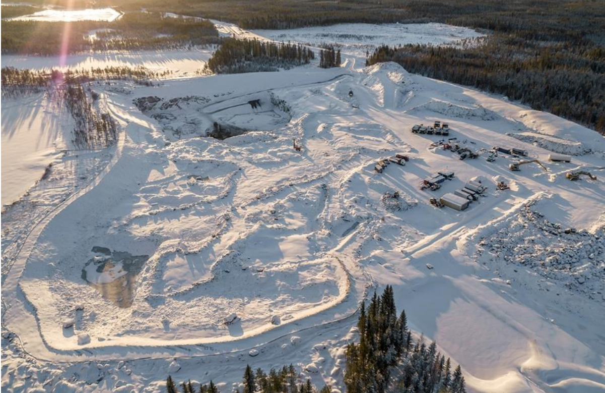
Syväjärven kaivosalue tammikuussa 2024. Tarvekiveä on louhittu Malmi- ja Rikastetien sekä muun infrastruktuurin rakentamiseen.
