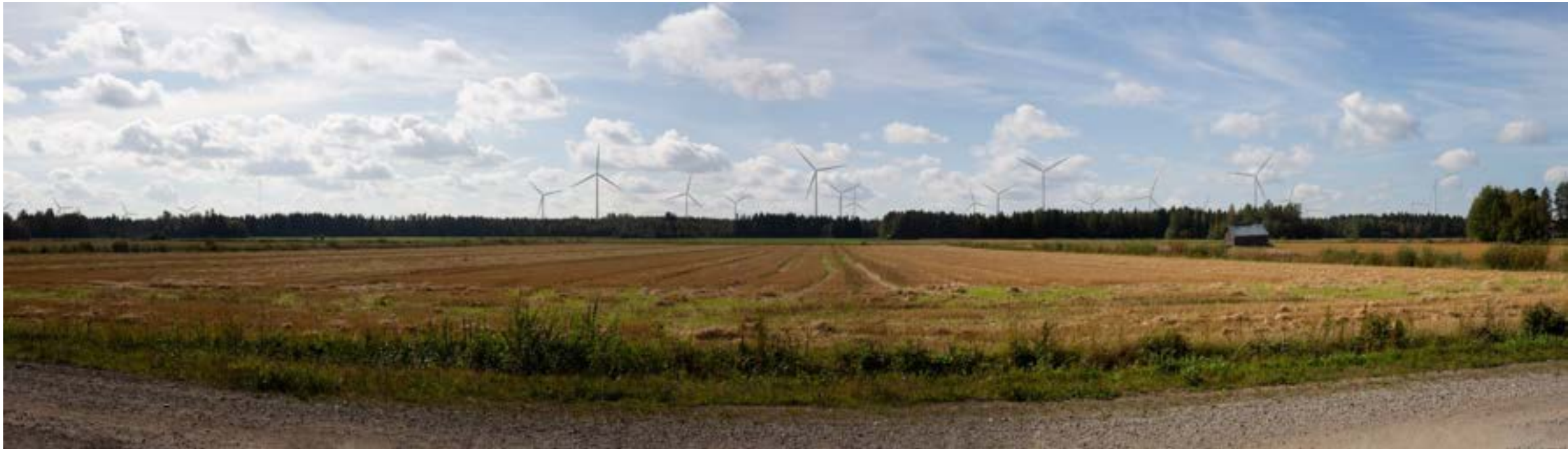
Kuvauspaikka 7b, Lestijokilaakso pohjoinen, Toholammin Välikankaalta lounaan suuntaan, etäisyys lähimpiin voimaloihin 2,3 km
